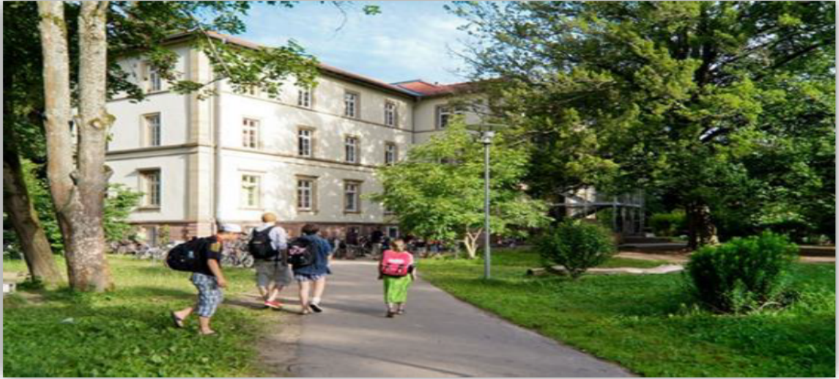
Abb. 3: Eingang des Schulhauses von Süd-West (eigene Abbildung)
