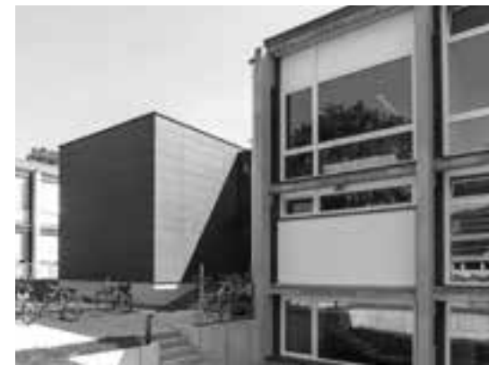
Sanierung und Anbau Turnhalle
