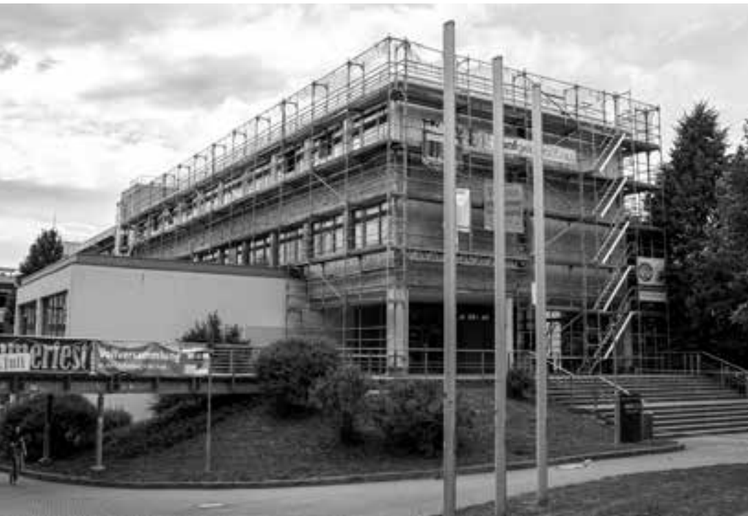
Aufstockung des KG 5
