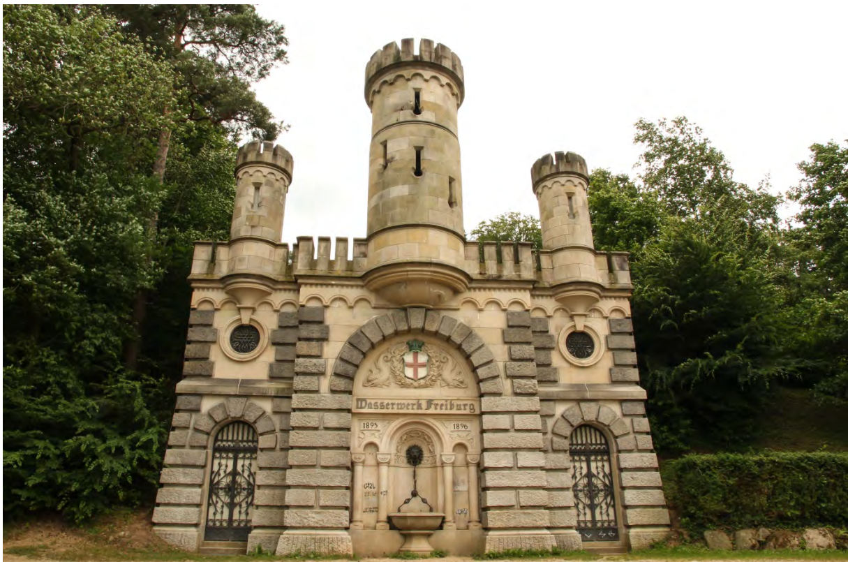
Abb. 1: Das Wasserschlössle 2018. Foto: Matthias Baumann.
