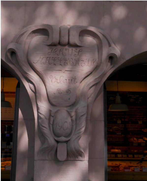
Abb. 3: Haus Mallebrein, Bauinschrift mit Baujahr 1905. Foto: Frank Hack.
