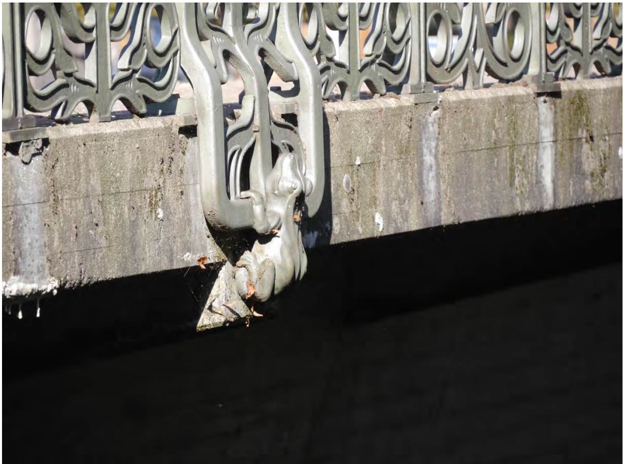
Abb. 2: Gusseisernes Detail der Oberaubrücke, 2018. Foto: Yoris Bringmann.
