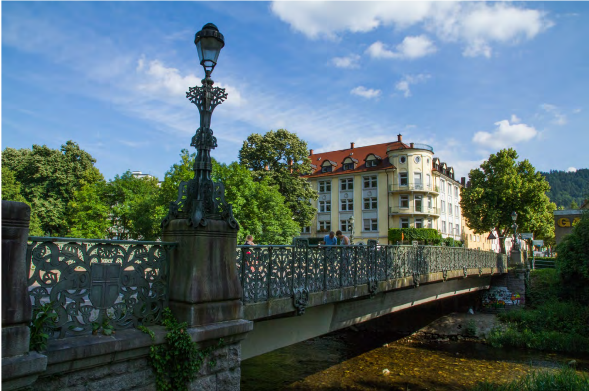
Abb. 3: Oberaubrücke 2018. Foto: Matthias Baumann.
