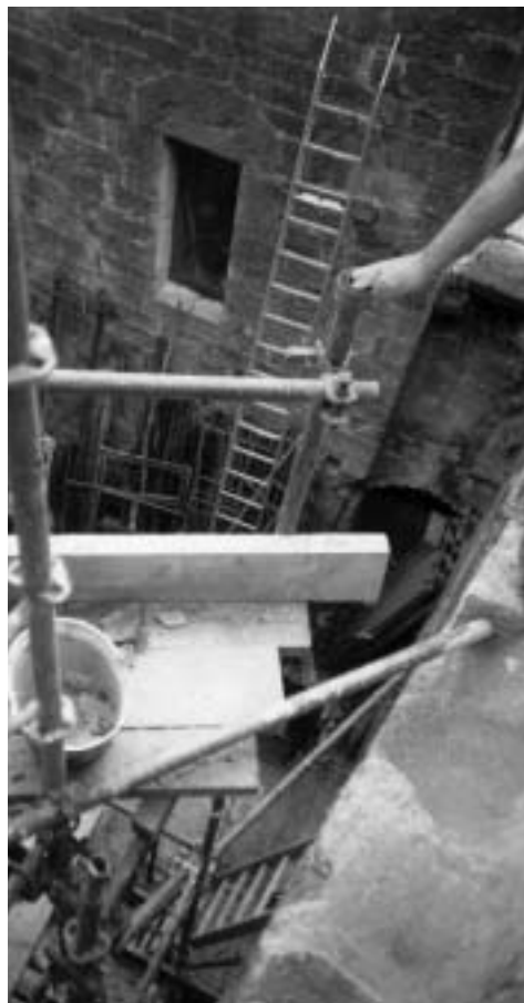
Le travaux de sécurisation dans la cuisine médiévale.
